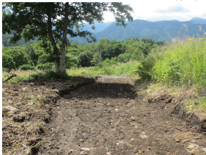
火入れを安全確実にする防火帯。完成間近です！
