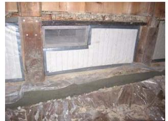
はがした床下の壁は薄いとタン1枚。ここには断熱材として古畳を使うことにしました。町内の畳屋さんが古畳をわけてくれたので、通風口を残し断熱にしました。いずれ建物全体を覆う外断熱にも古畳を使用するつもりです。
