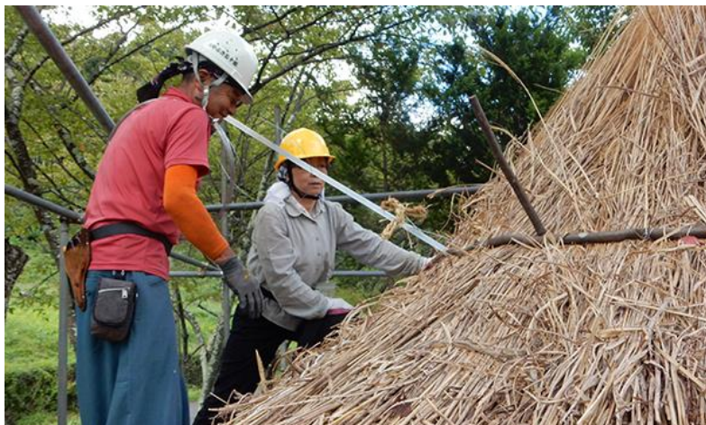
左・茅葺き作業(健康村 HP より)
