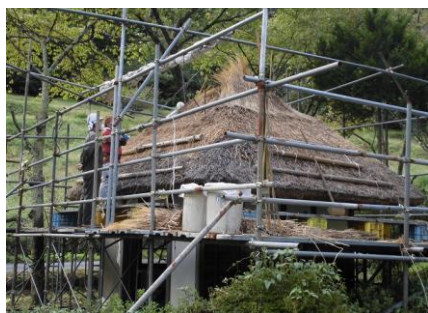
足場が組まれた元水車小屋
