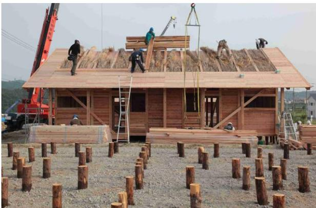
東日本大震災 板倉の応急仮設住宅 屋根の断熱材として茅を利用（福島県いわき市） 富士山麓御殿場からトラック4台、群馬県みなかみ町から1台、茨城県石岡市八郷から1台、合計6台分の茅が支援された。（写真 安藤邦廣）
